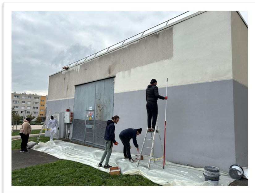
Mise en peinture d'une chaufferie
