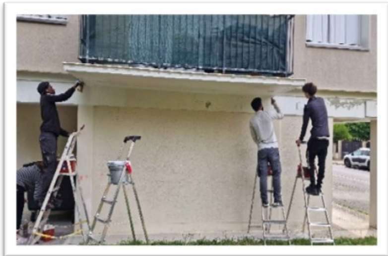
Mise en peinture du ravalement extérieur sur les parties basses de 5 bâtiments
