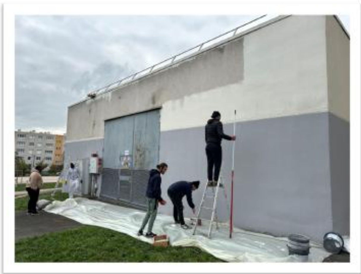
Mise en peinture d'une chaufferie
