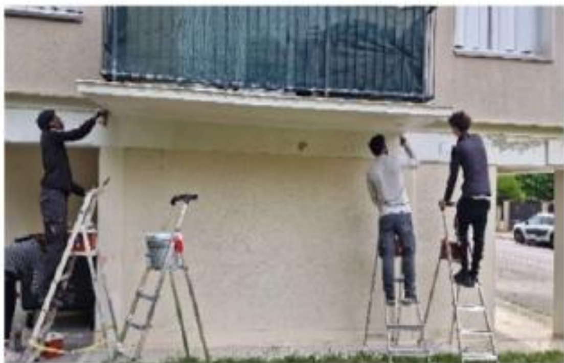
Mise en peinture du ravalement extérieur sur les parties basses de 5 bâtiments
